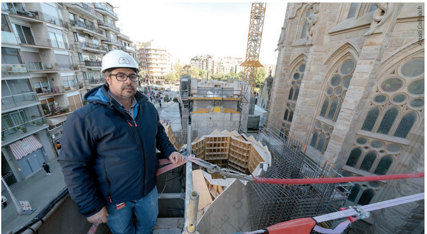
Xisco Llabrés nos muestra el interior de la capilla, de 9x9 metros, actualmente lleno de cimbras de madera.
