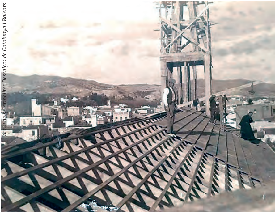
Obres a la teulada i al campanar que evidencien la manca de mesures de seguretat. Presumiblement, el frare amb l'hàbit és Manuel de Santa Teresa, director de l'obra.
