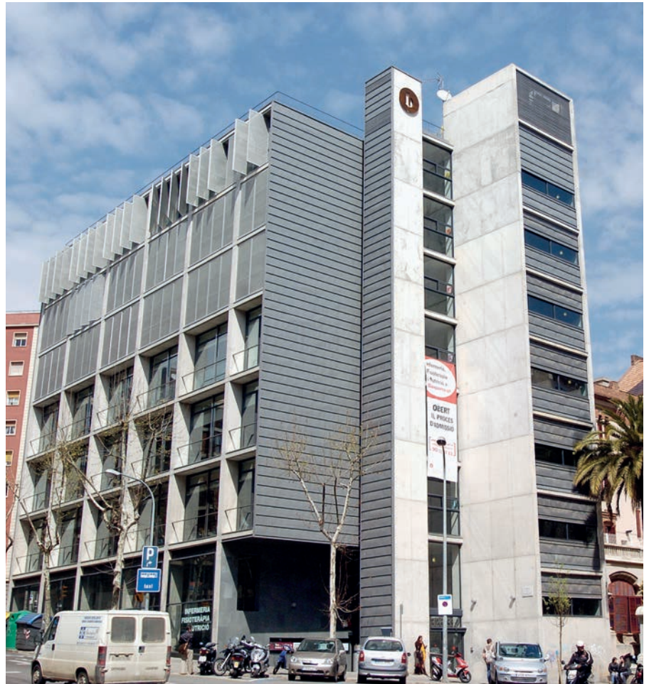
Edifici de la Facultat de Ciències de la Salut Blanquerna, al carrer Padilla de Barcelona.
