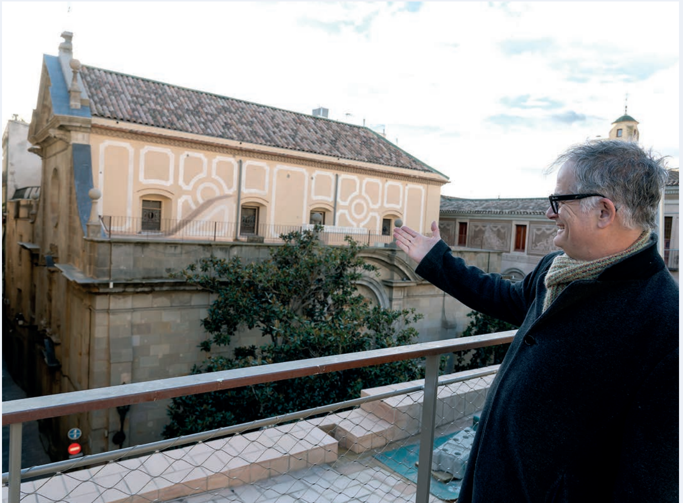
L'arquitecte Joan Claudi Minguell mostra la façana lateral i la teulada, ja restaurades, de l'església de Sant Sever.
