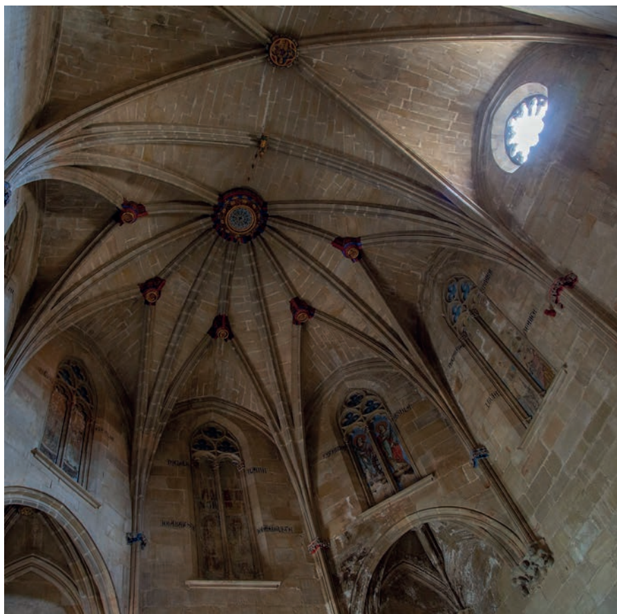
La complexa volta en forma d'estrella de la capella.
