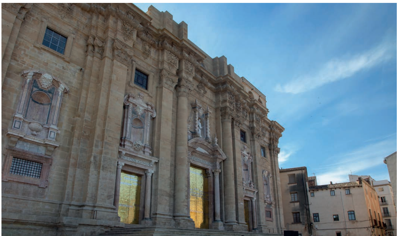
La fachada barroca acaba de ser restaurada hace pocos meses.
