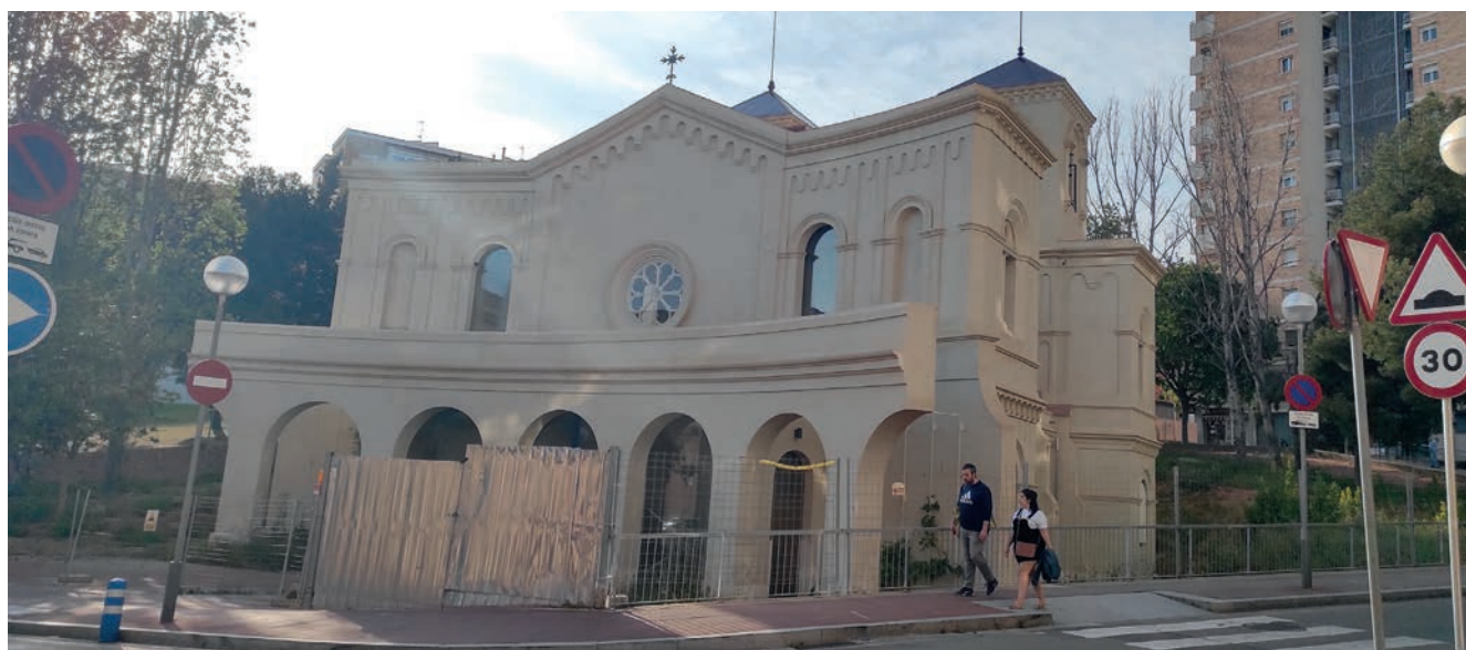
Construcció de la nova parròquia de Sant Rafel, de Barcelona, aprofitant l'estructura de l'església de l'antic Institut Mental de la Santa Creu.
