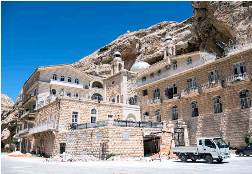
Obras de rehabilitación en el monasterio de Santa Tecla, un complejo construido a partir del 90 dC en recuerdo de la discípula de san Pablo.
