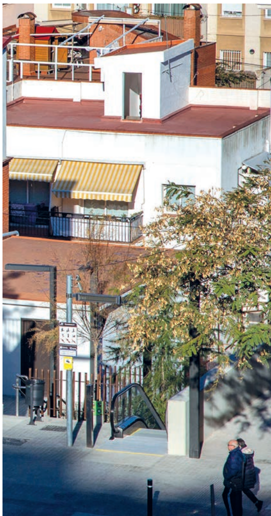
Placas solares de la parroquia de San Cipriano.
