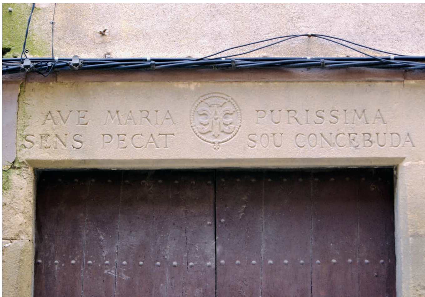
Dintel en la calle de Gurb en Vic.
