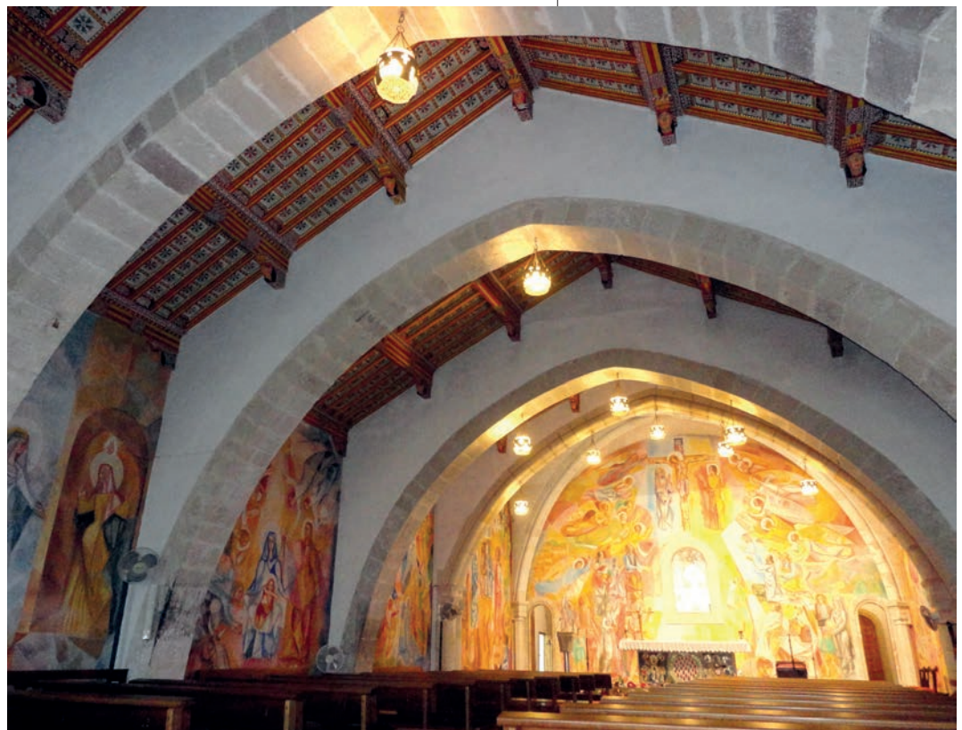
Los arcos góticos de Paret delgada sostienen las vigas originales de la edad media.
