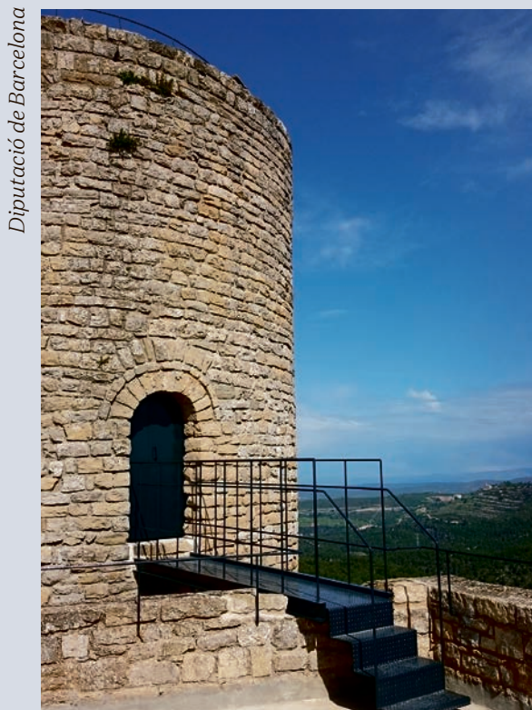
Sant Pere Sallavinera. Restauració del Castell de Boixadors.
