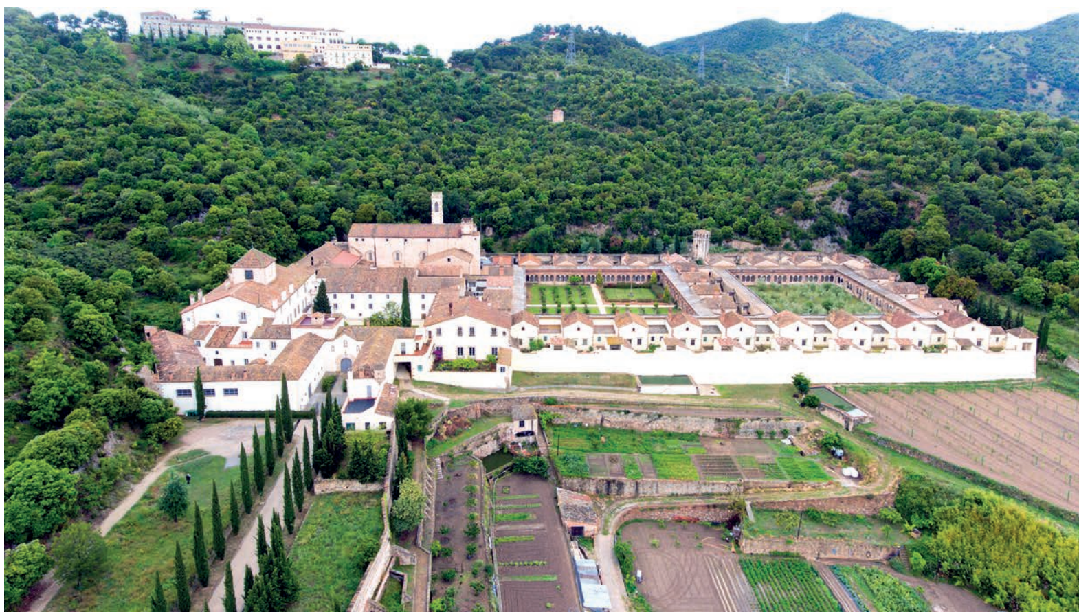
Vista aèria de la Cartoixa de Montalegre. És de l'any 2017 i s'aprecia tot el conjunt arquitectònic i també l'antic Seminari menor de la Conreria. / Antonio Guillén / Museu de Badalona
