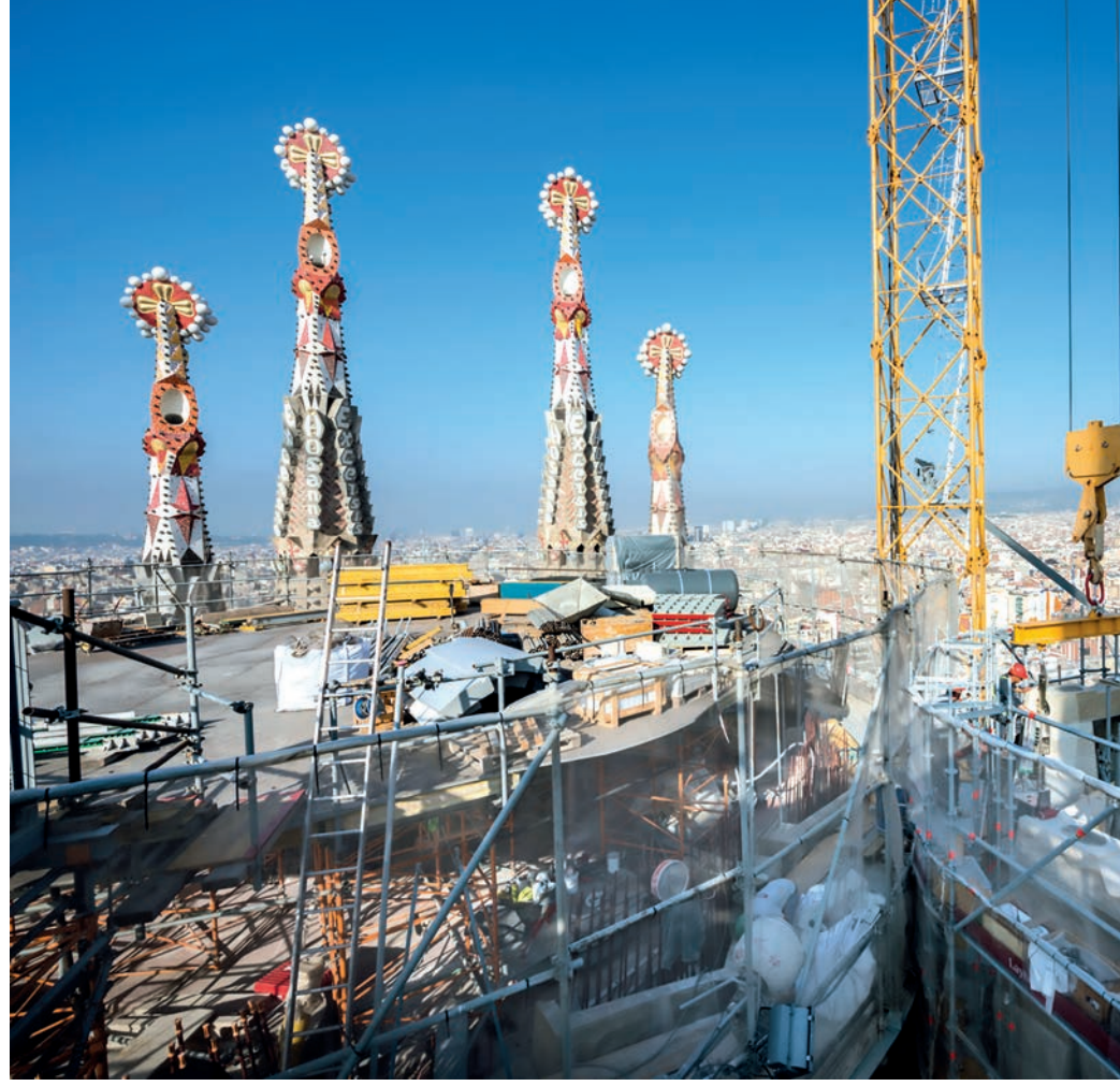
Construcción de la torre del evangelista Lucas.
