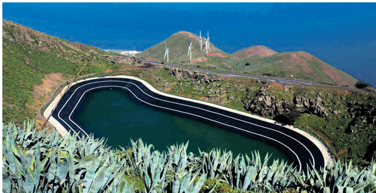
Planta hidroeléctrica de Gorona del Viento. En primer plano el depósito superior y al fondo los molinos de viento (Endesa).
