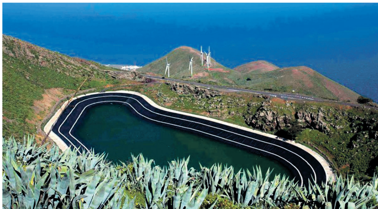
Planta hidroelèctrica de Gorona del Viento. En primer pla el dipòsit superior i al fons els molins de vent (Endesa).
