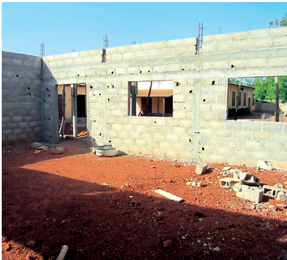
Las aulas, durante el proceso de construcción.
