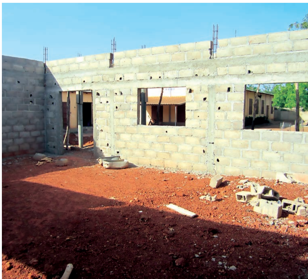
Les aules, durant el procés de construcció.
