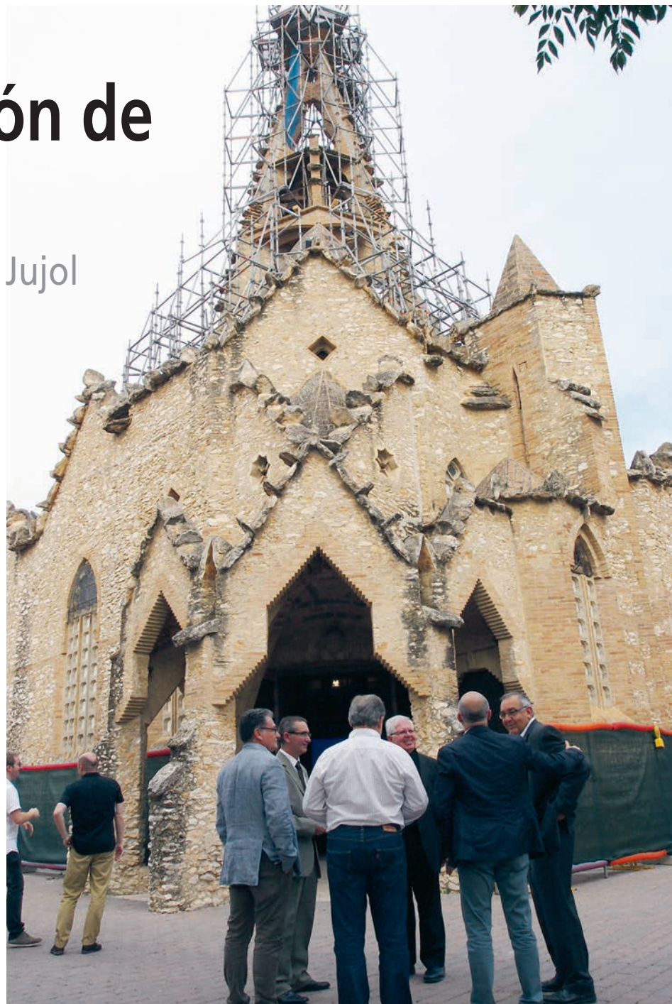
Aspecto exterior de la iglesia de Vistabella, en el inicio de las obras. / Joan Boronat
