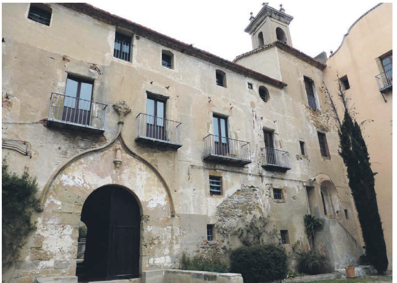
La fachada noble, con la torre y la portada gótica.
