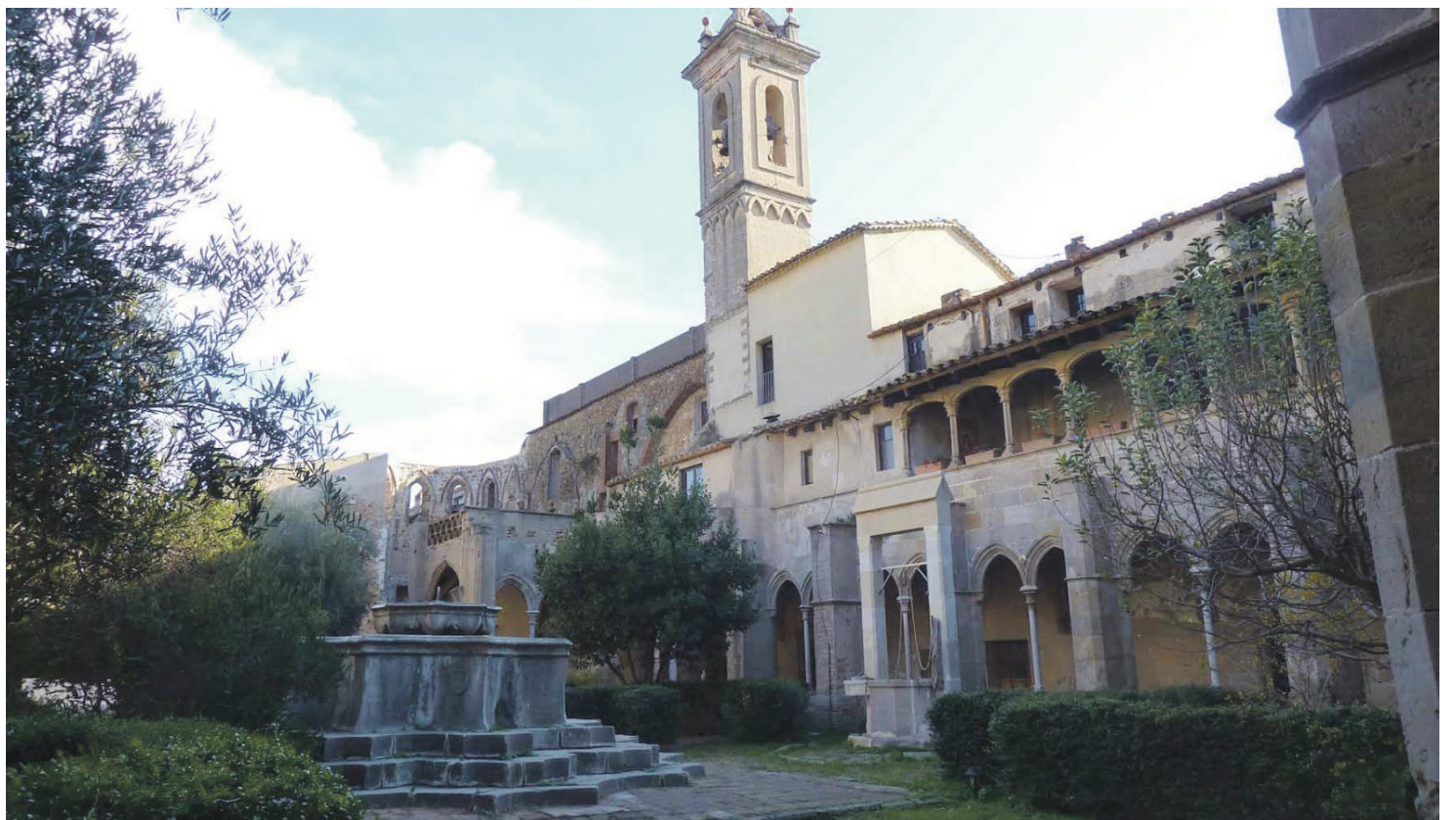
El espacio central del claustro con la iglesia derrumbada al fondo.
