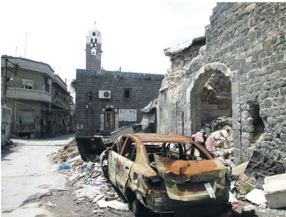
Destrucción masiva en Homs.
