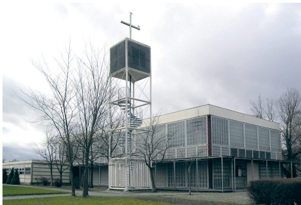
La antigua catedral, construida en 1973, ha sido derribada porque amenazaba con hundirse.
