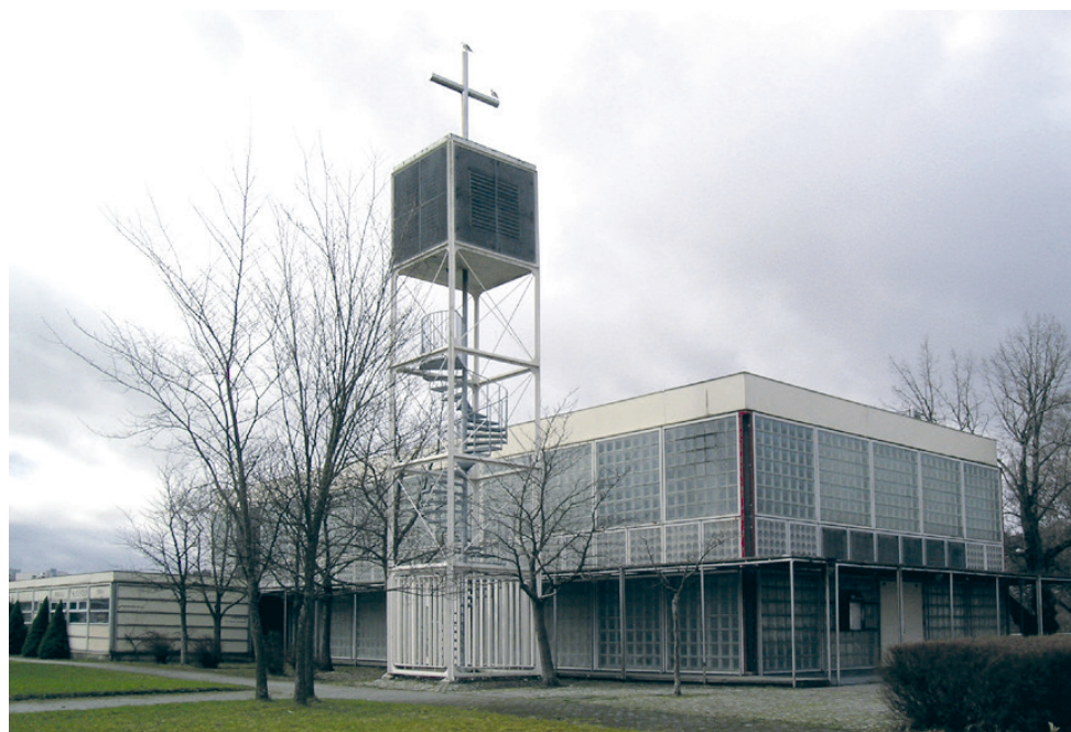
L'antiga catedral, construïda el 1973, ha estat derruïda perquè amenaçava d'esfondrar-se.
