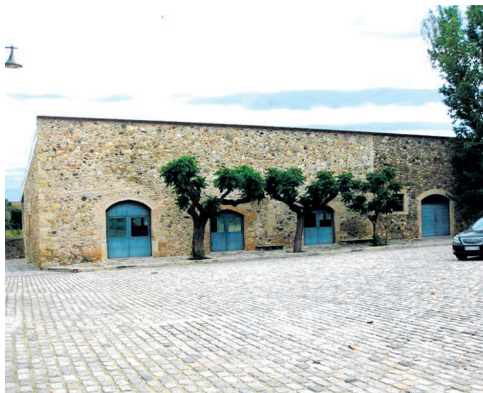
Edificio que será rehabilitado para Centro de Visitantes. / Monasterio de Poblet
