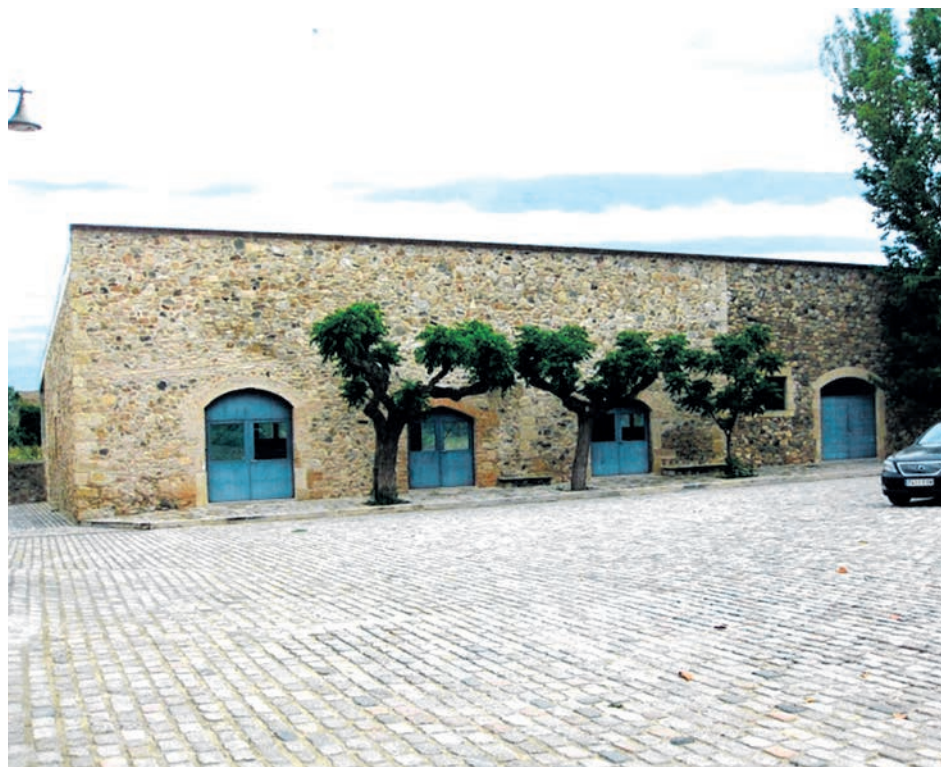
Edifici que serà rehabilitat per a Centre de Visitants. / Monestir de Poblet
