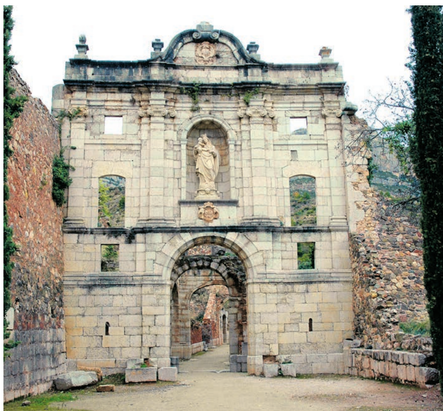
Entrada a la cartuja de Scala Dei.
