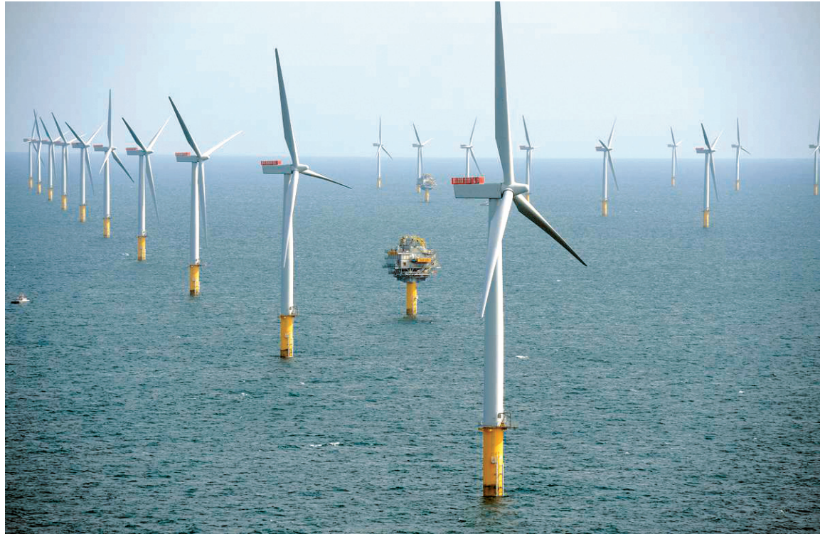
Parque eólico de «London Array», situado en el estuario del Támesis.
