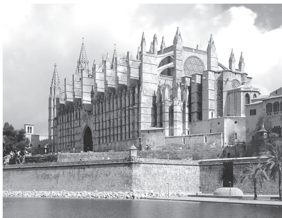
Entre 1914 y 1915, Gaudí acabó la reforma en la Seo.
