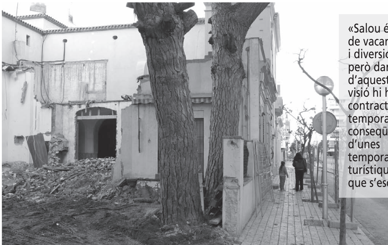
Antiga casa de Càritas.
