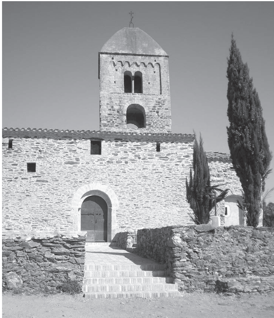
La iglesia de Santa Coloma de Fitor (Baix Empordà), después de la restauración.
