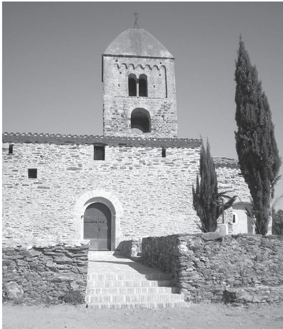
L'església de Santa Coloma de Fitor (Baix Empordà), després de la restauració.
