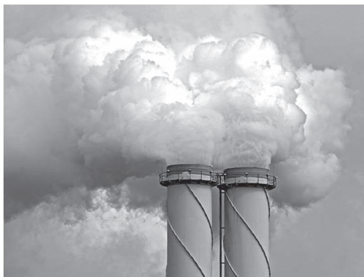
Central tèrmica de carbó a Rotterdam (Països Baixos).
