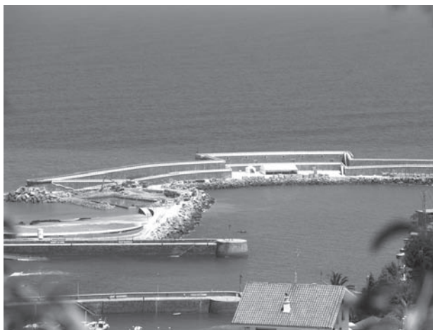
Instalación de aprovechamiento de energía de las olas marinas en Mutriku.
