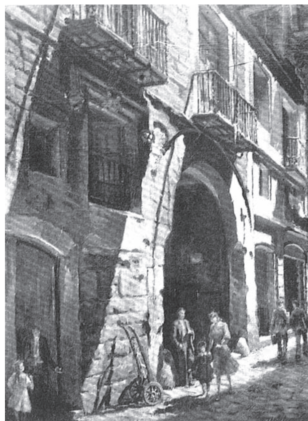
Primera sede del Conservatorio Municipal, en la calle Lledó.
