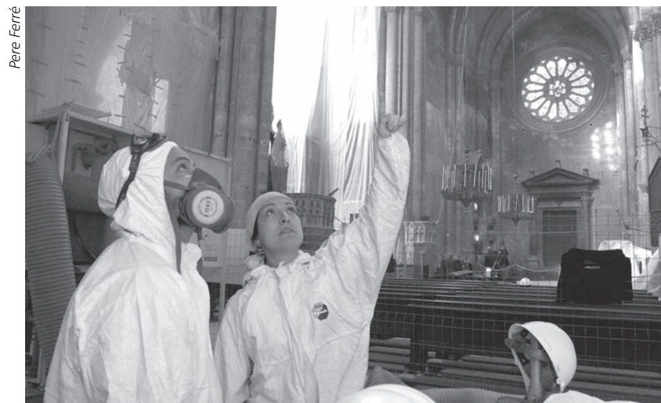
Los trabajos de restauración prosiguen a buen ritmo.
