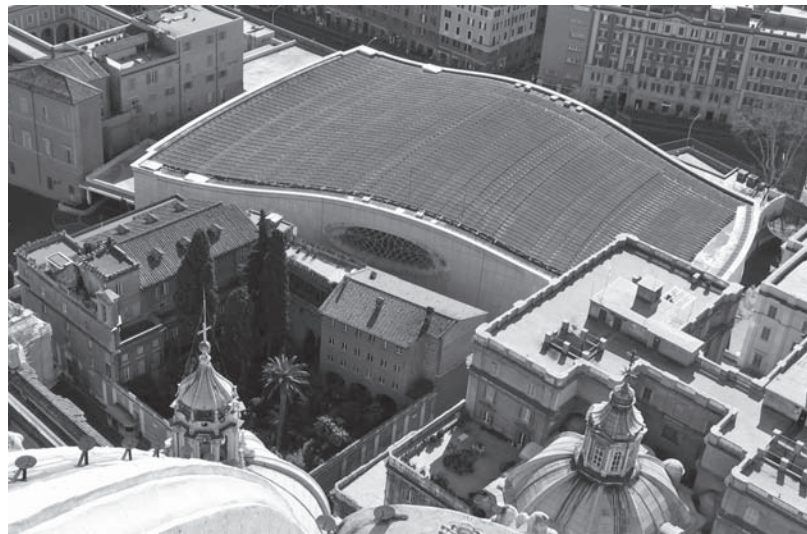
Panells solars instal·lats a la teulada de l'Aula Pau VI del Vaticà.
