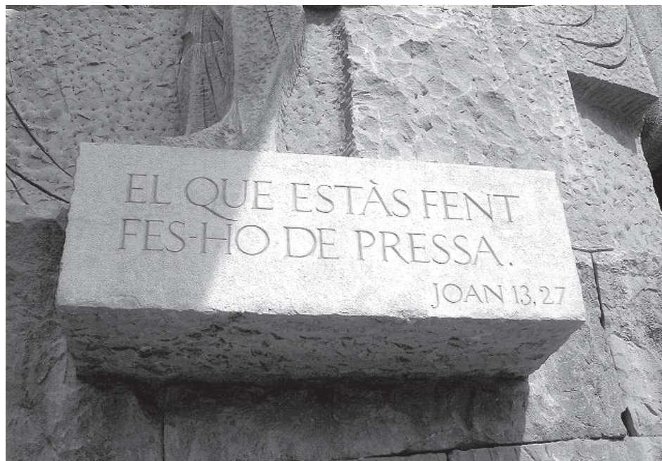
Detalle de la fachada de la Pasión. Foto: Etsuro Sotoo
