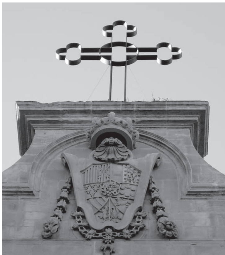
La fachada de la catedral ya luce la nueva cruz.
