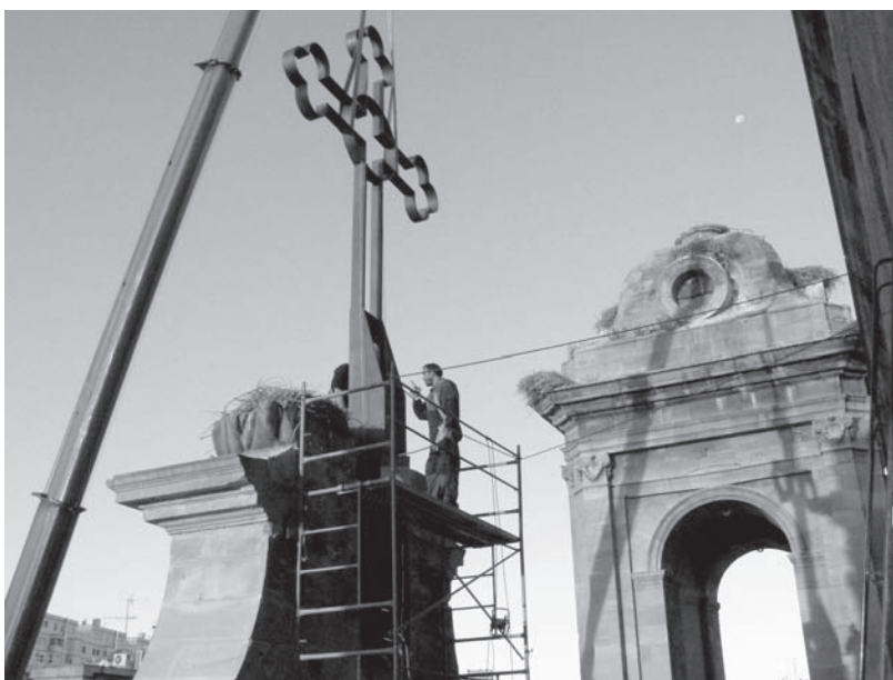
La operación de instalación comportó un laborioso trabajo.
