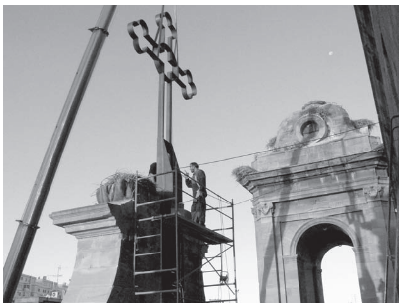
L'operació d'instal·lació va comportar un treball laboriós.
