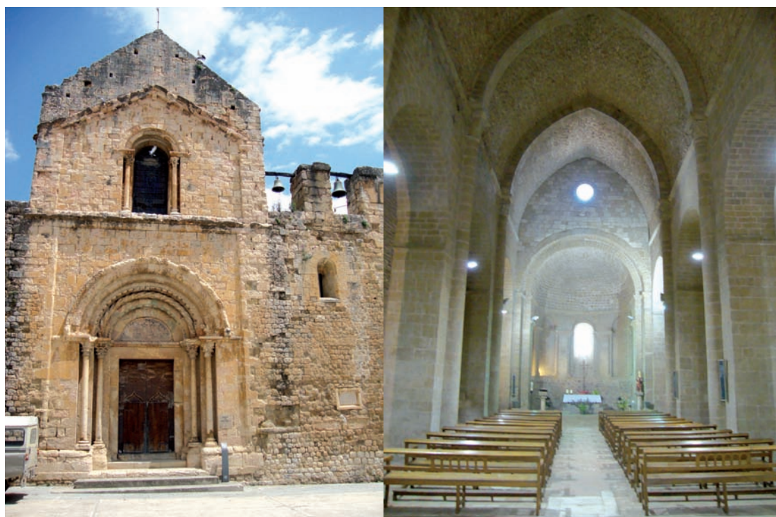
Fachada e interior de Santa María de Lladó.
