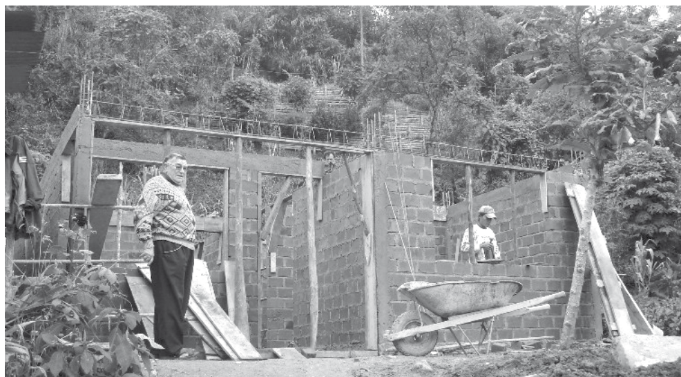
Construcció d'una de les cases a Colòmbia.
