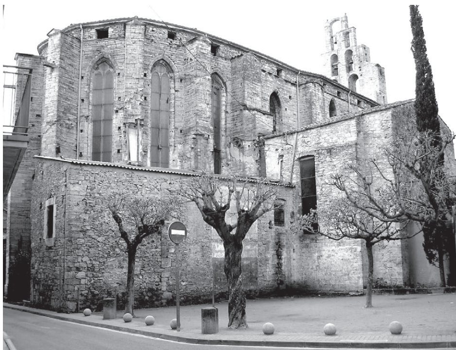
Los edificios adosados al ábside escondían su perfil del más puro estilo gótico catalán.
