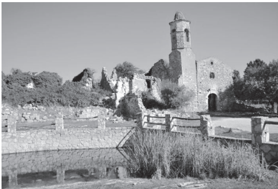
La iglesia de San Salvador de La Mussara, en fase de restauración.
