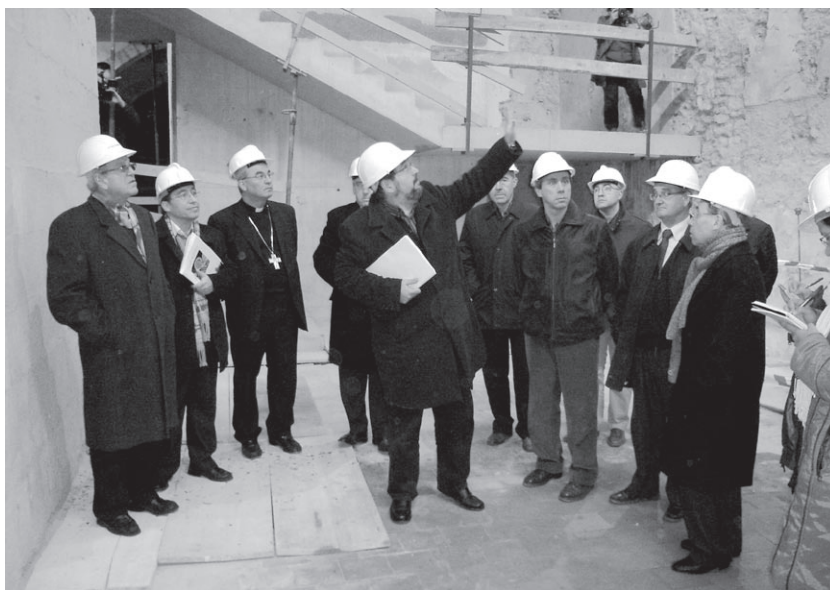
Entre otras autoridades, Mons. Jaume Pujol visitó las obras.
