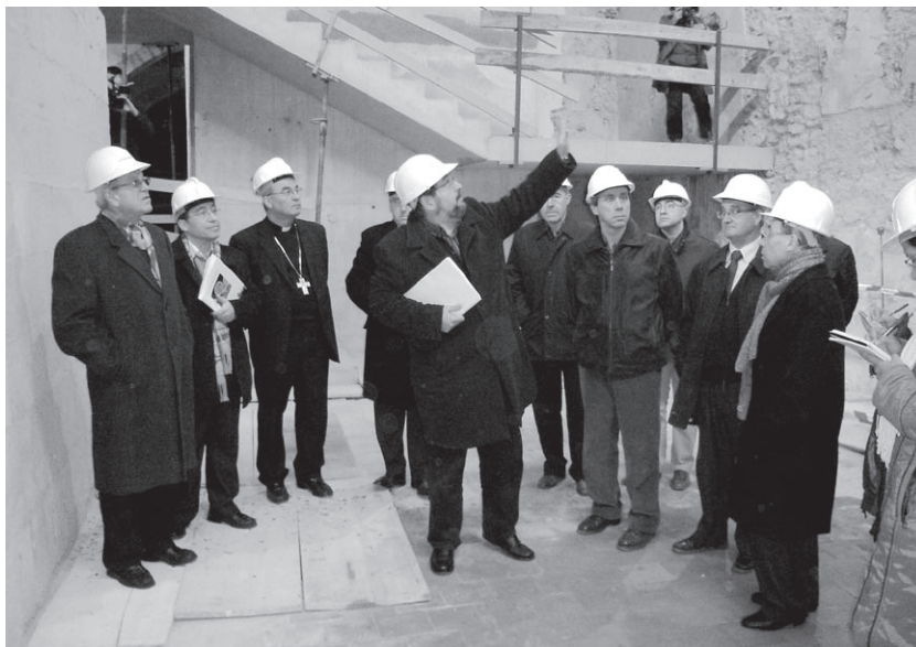
Entre altres autoritats, Mons. Jaume Pujol va visitar les obres.
