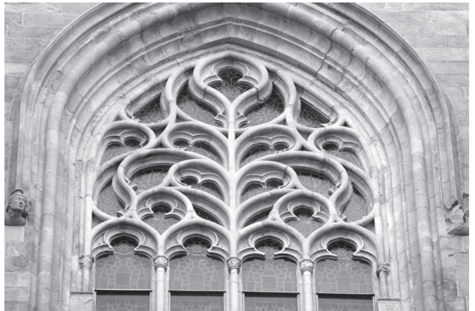
La traceria gòtica d'un dels finestrals restaurats de la catedral de Girona.
