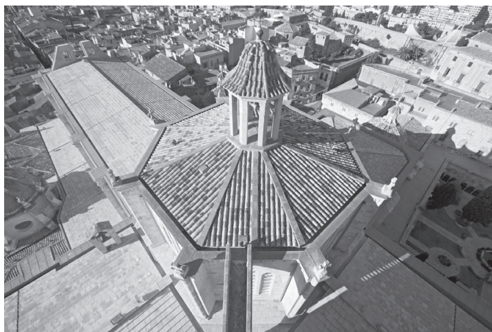
La tercera fase de la restauració, que incloïa una nova coberta a la teulada, ja ha finalitzat.
