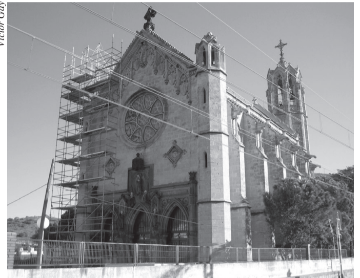
Treballs de restauració del conjunt de l'església parroquial de Portbou.
