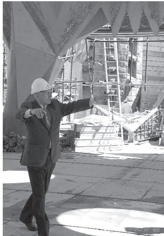
L'arquitecte en cap, Jordi Bonet, mostra l'estat de les obres.
