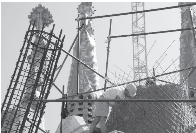
Els operaris continuen treballant a la Sagrada Família.
