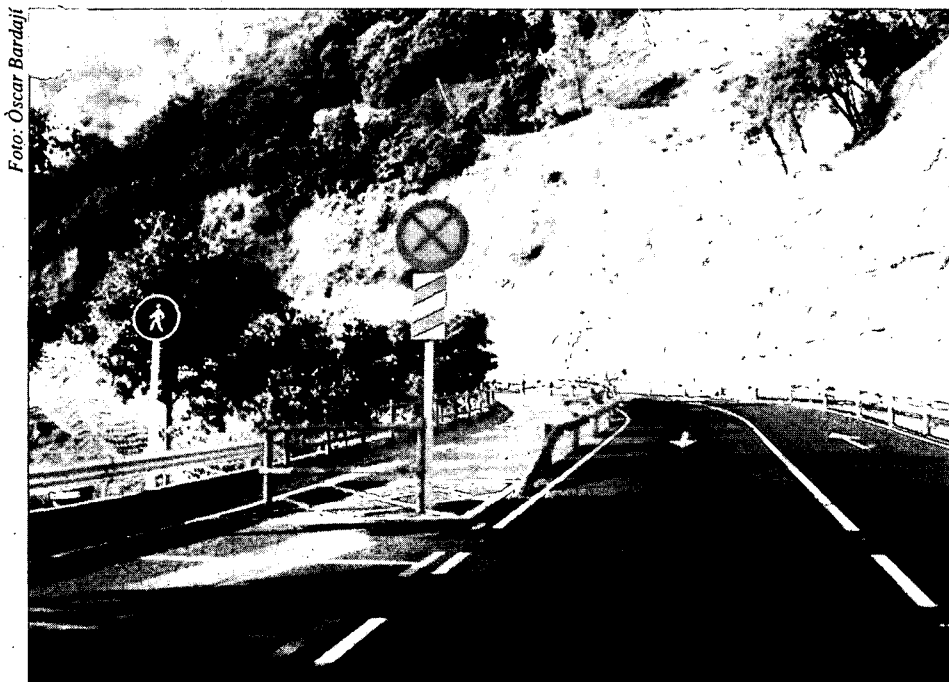
La carretera ja ha quedat senyalitzada, pintada i asfaltada.
