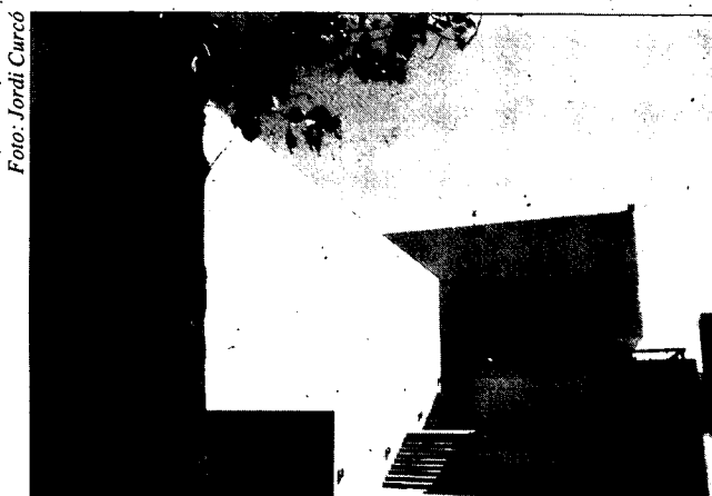
Les obres del nou edifici del Museu de Lleida estan molt avançades i es preveu que serà inaugurat el novembre.
